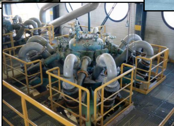
Гидроциклоны Hydro-zyklone (63 \mu\text{m} )
